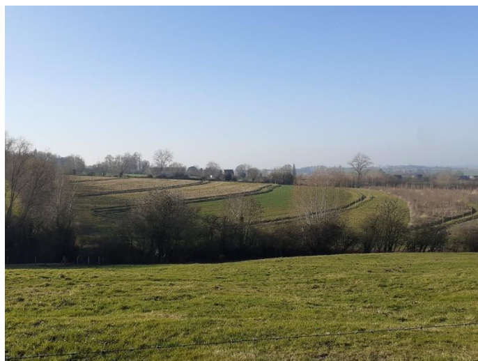
Figuur 96: Greppel-bermstructuren in Westouter om infiltratie te bevorderen en erosie tegen te gaan.
