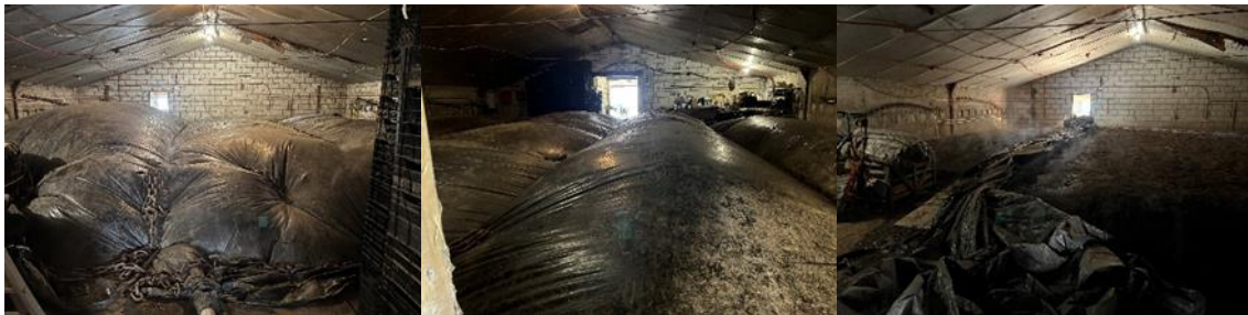
Figuur 48: Foto links en midden tonen hoe de zeilen bol staan en op hun plaats gehouden worden door zware kettingen, de foto rechts toont de dampende bodem net na het verwijderen van de zeilen.
